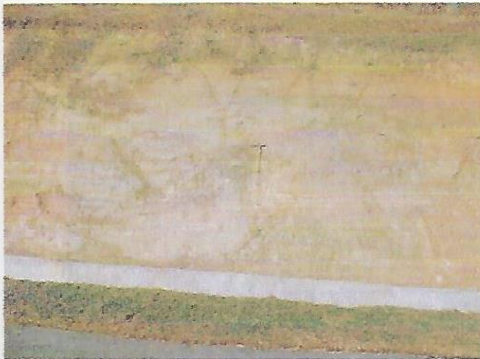
Figura 4.1-16: Vista de solo residual maduro, por vezes jovem, de cor castanha clara a amarelada, espessura inferior a 1 m.
