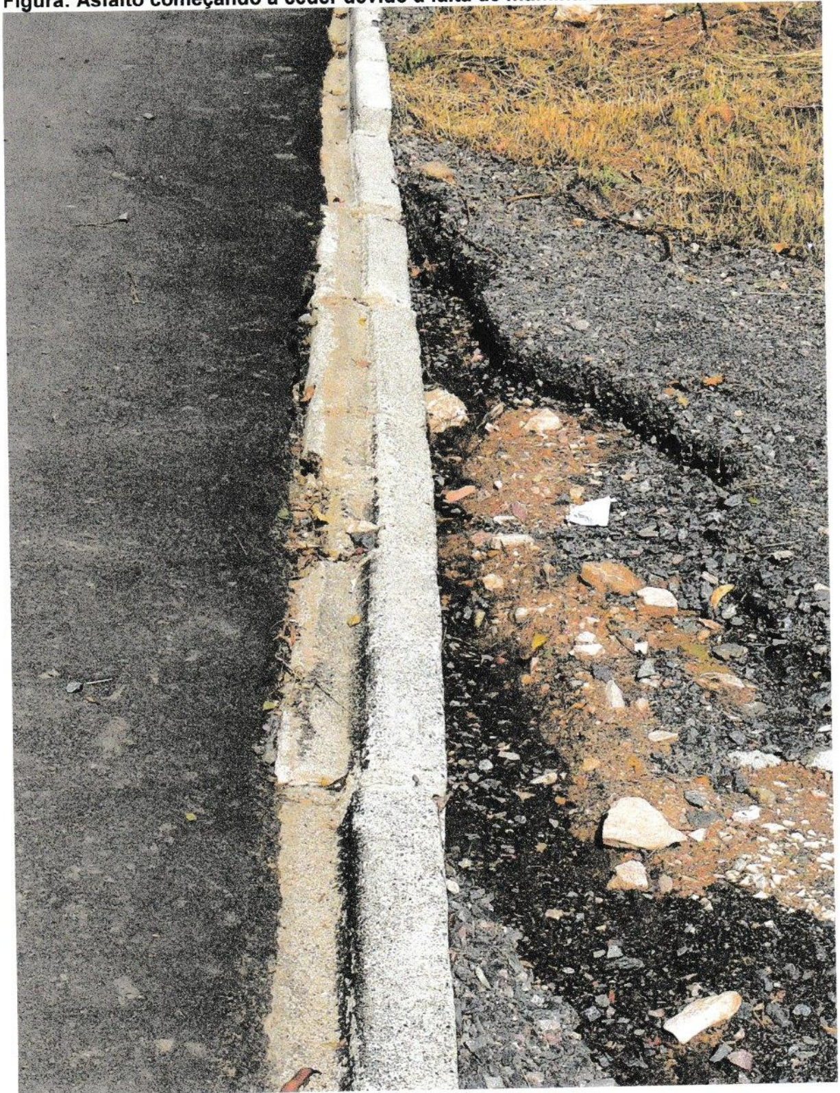
Figura: Asfalto começando a ceder devido a falta de manilhamento.
