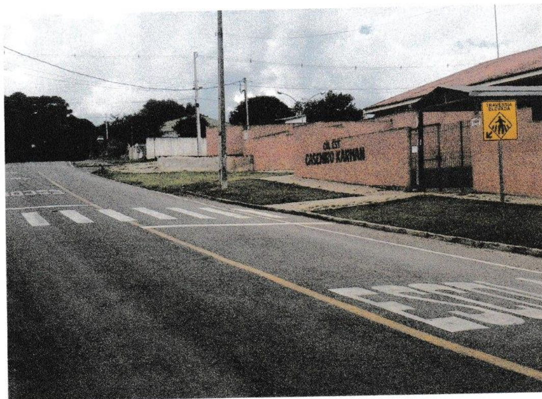
Imagem: Instalação de guia elevada Fonte: Anderson Soek
