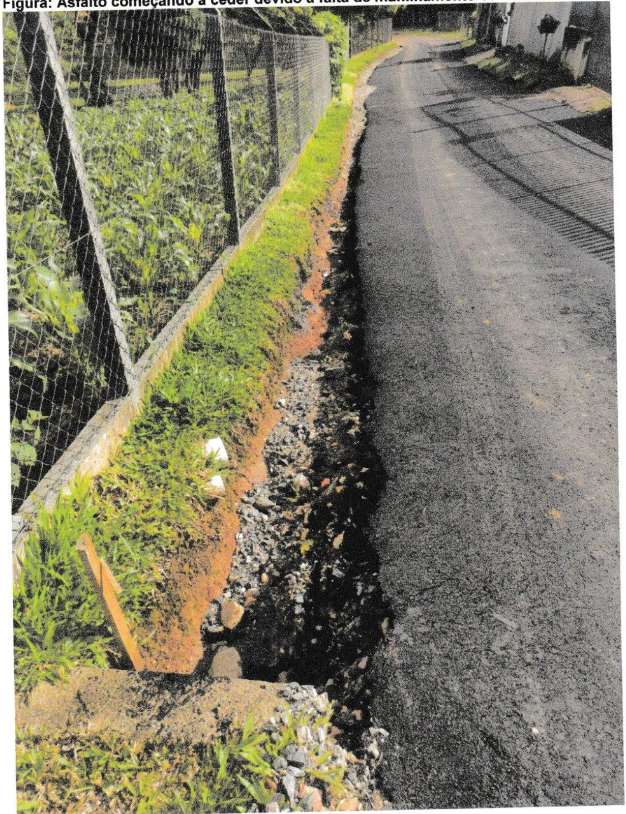
Figura: Asfalto começando a ceder devido a falta de manilhamento ou canaletas.
